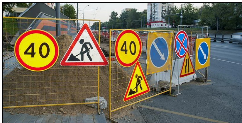
Рис. 1. Вариант использования временных дорожных знаков
